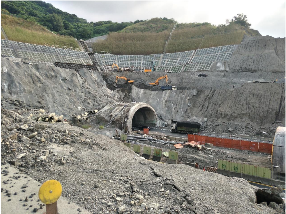
由北往南照的工程全景。
