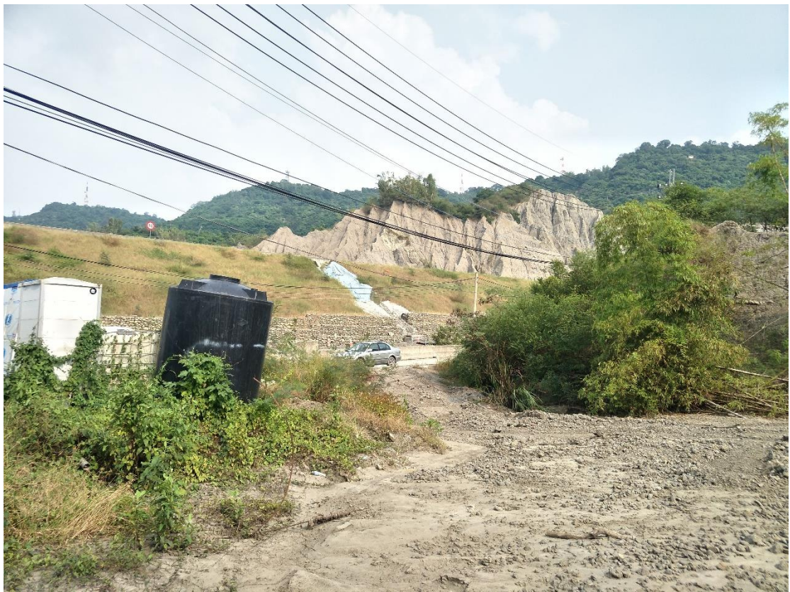
高速公路下方的泥岩填方壓實照片。
